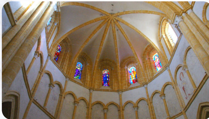
Voûtes du chœur
