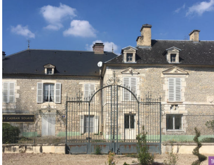
16. La maison dite « Cadran Solaire »
